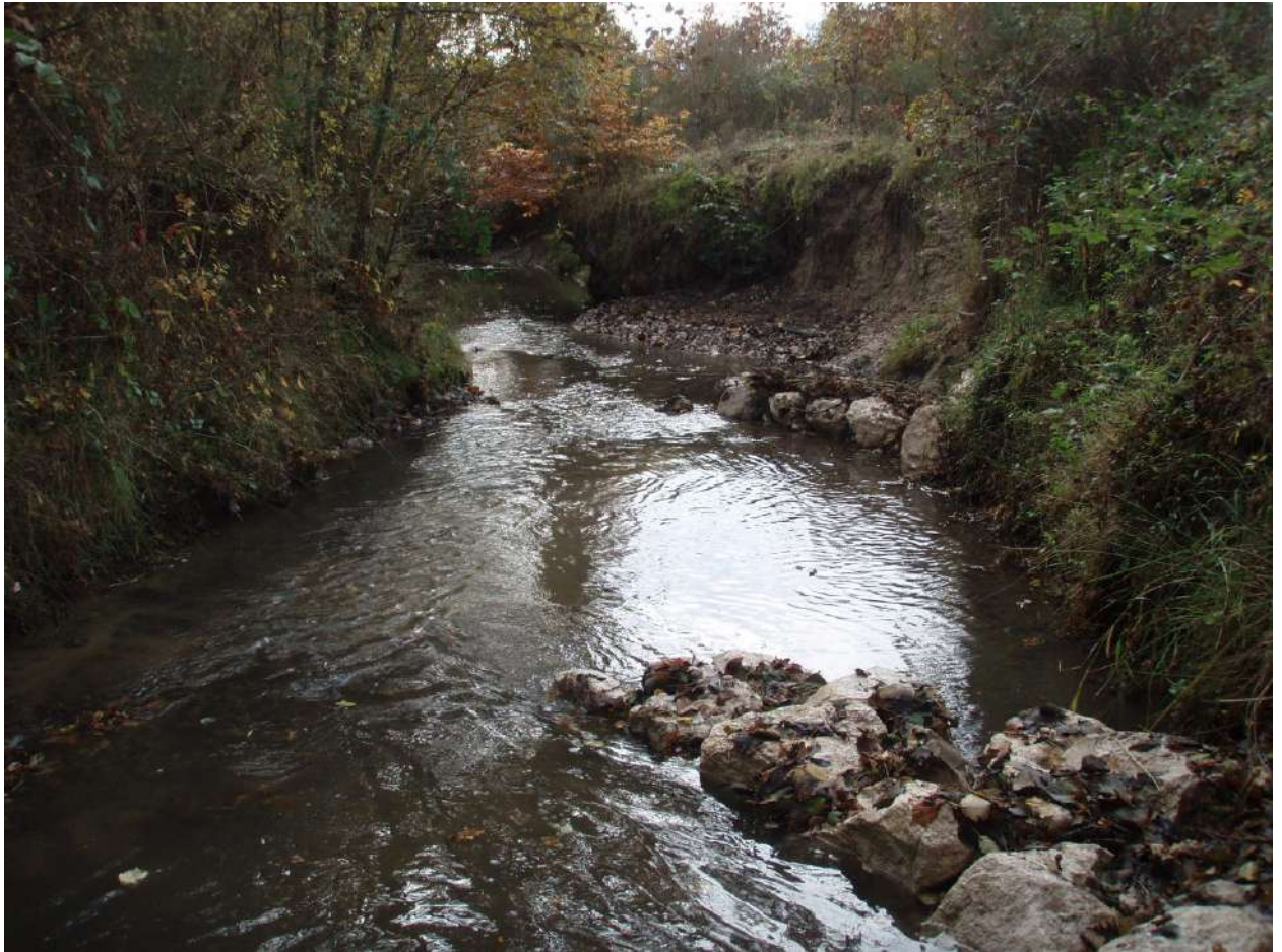
Illustration 7: Mise en place d'épis sur le Bourillon (un mois après les travaux) (crédit photo SEBB)
