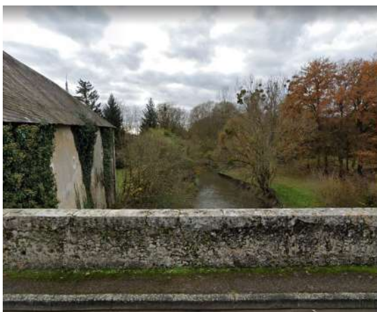
Illustration 2: Vue depuis la route vers la zone de travaux (Source: google street)
