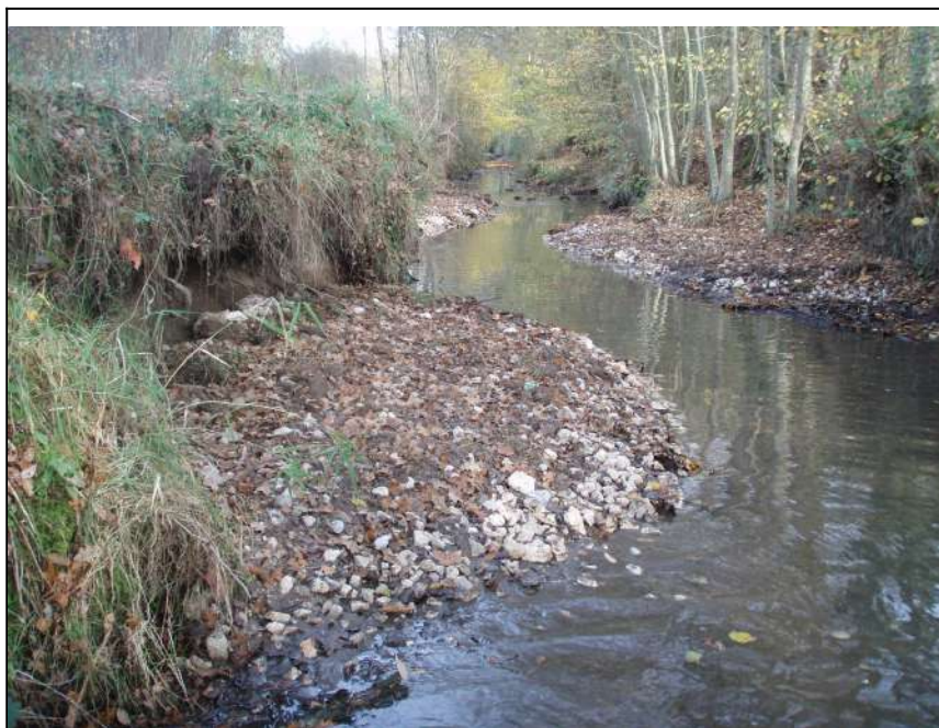
Illustration 8: Mise en place de banquettes (crédit photo SEBB)
