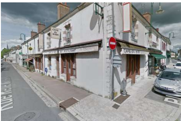
Illustration 2: Vue depuis les halles vers le site de travaux (Source: google street)
