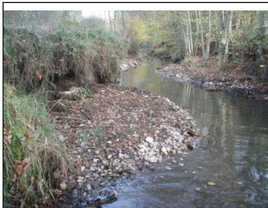
Illustration 6: Mise en place de banquettes (crédit photo SEBB)
