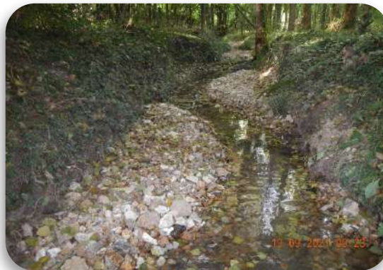
Illustration 7: Recharge granulométrique sur le Valaire (Crédit photo: SEBB)
