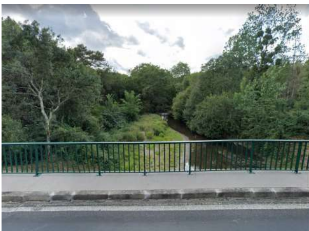
Illustration 2: Vue vers le site de travaux Thoury (Source: google street)
