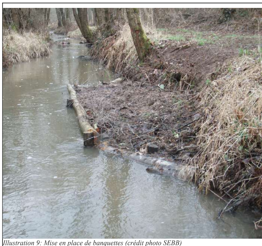
Illustration 8: Mise en place de banquettes (crédit photo SEBB)
